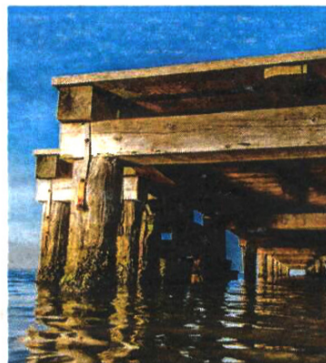
Una delle opere accessorie realizzate nell'area lagunare
