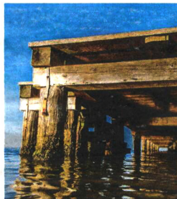
Una delle opere accessorie realizzate nell'area lagunare
