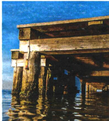
Una delle opere accessorie realizzate nell'area lagunare
