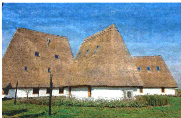
I quattro casoni realizzati di recente che il Comune di Codevigo ha affidato alla cooperativa
