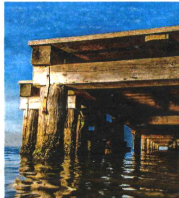
Una delle opere accessorie realizzate nell'area lagunare
