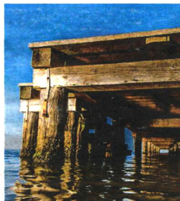
Una delle opere accessorie realizzate nell'area lagunare
