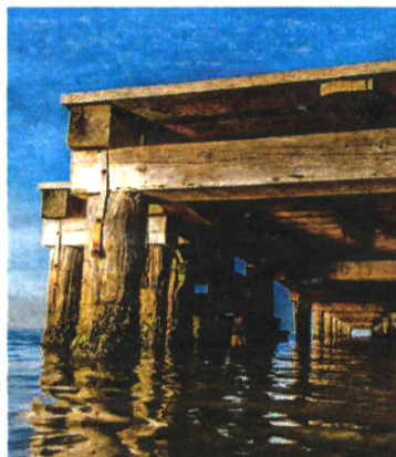
Una delle opere accessorie realizzate nell'area lagunare
